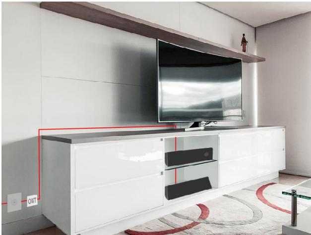
DTIO : Dispositif de Terminaison Intérieure Optique
